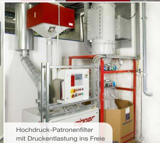
Schweißrauchabsaugung mit Patronenfilter und Brandlöschanlage
