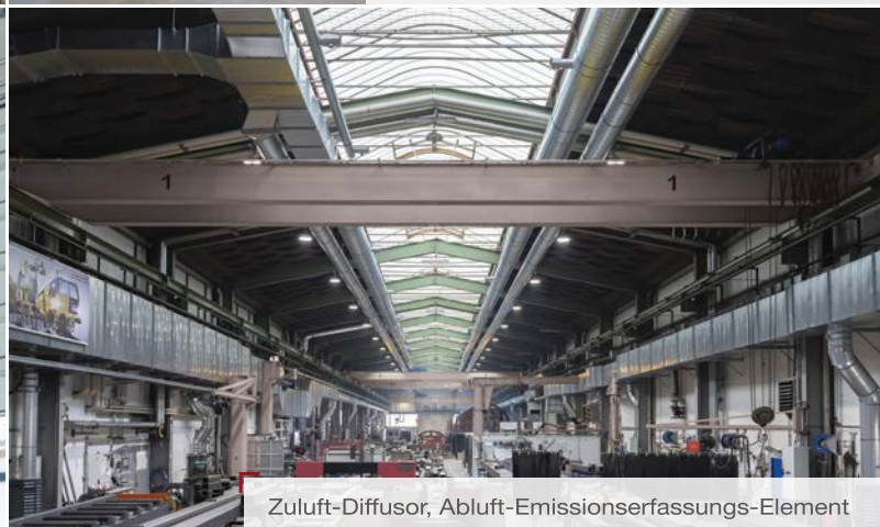
Schichtlüftung in Stahlbau-Schweißhalle
