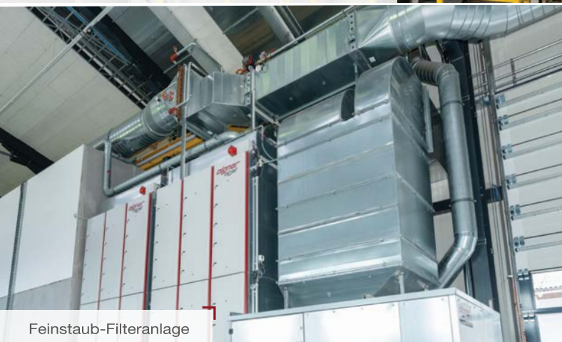
Patronenfilter-Anlage mit Wärmerückgewinnung
